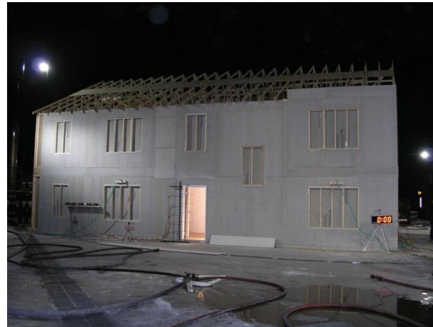
Εικ. 2.2 Διώροφη κατοικία (297 m 2 )(Φωτογραφία: UL)
